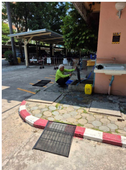
ภาพการถอดแผ่นกรองเครื่องปรับอากาศ
